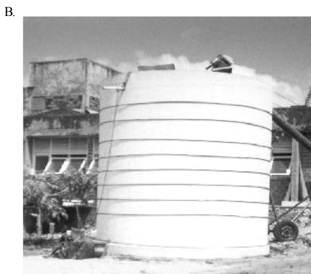
Silo com cintas metálicas
