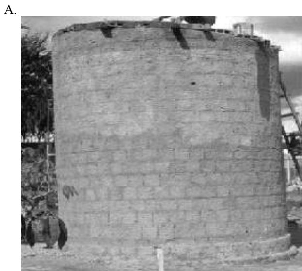
Silo em fase de construção
