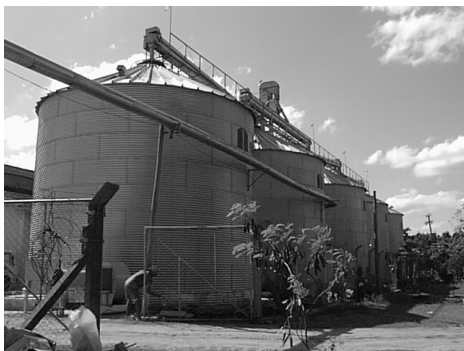
Figura 1. Silo da EEA.
